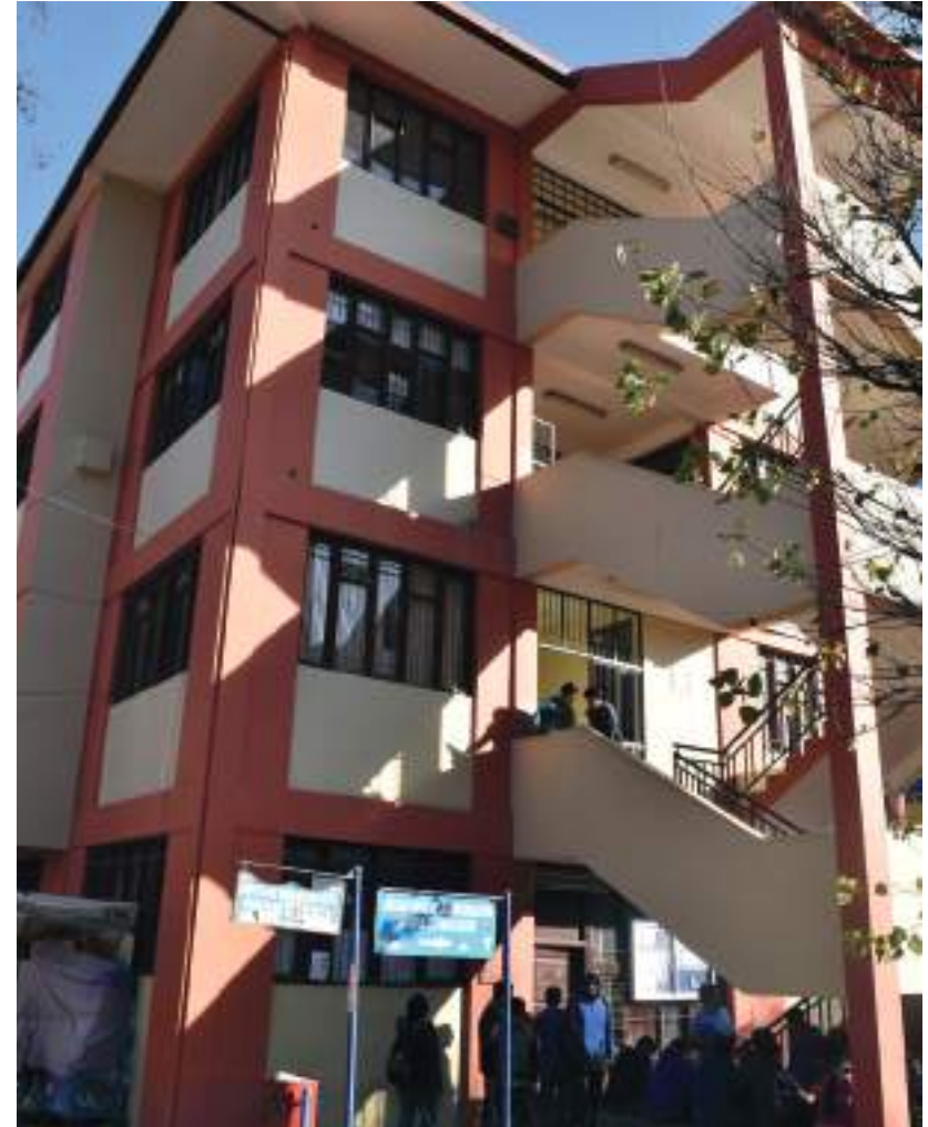
FUENTE: EDIFICIO MULTIFUNCIONAL DE LA FACULTAD DE CIENCIAS Y TECNOLOGÍA (2017).
